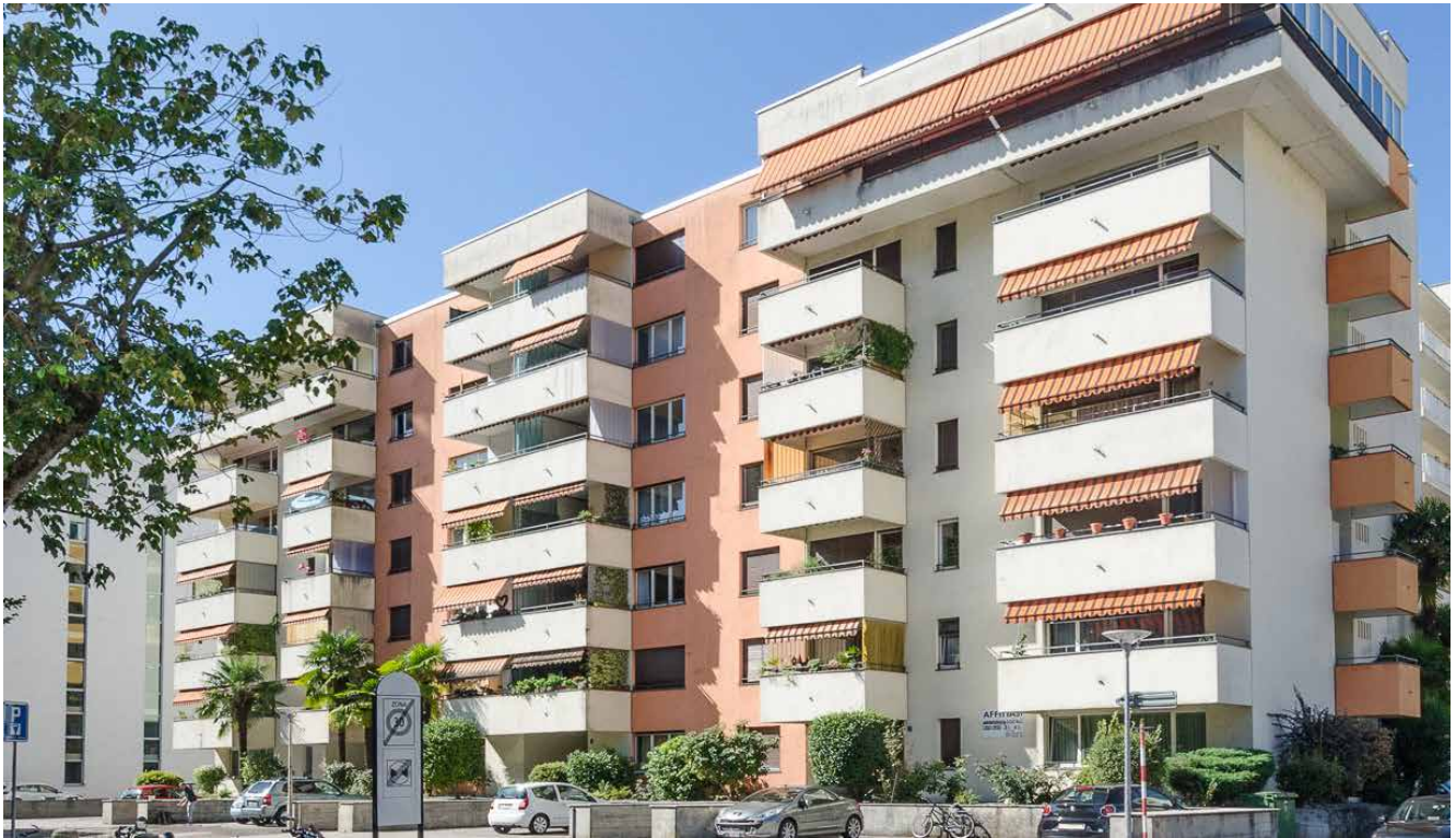
Locarno, Via della Pace 20
